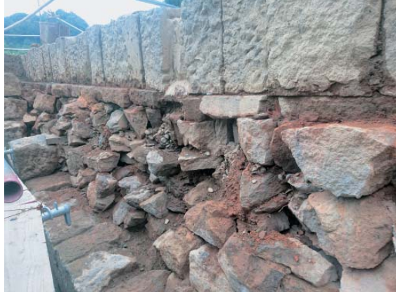
裏築露出状況
