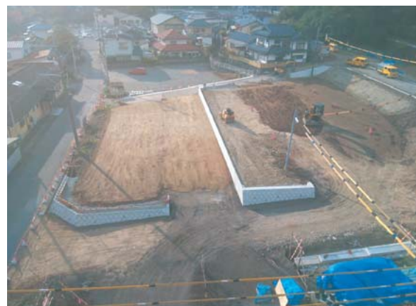
分譲地の工事の様子(11月1日時点)
