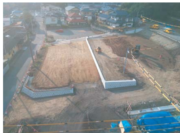
分譲地の工事の様子(11月1日時点)
