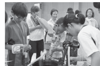
パイプのつなぎ目にしっかり塗って漏れを防ぎます。
