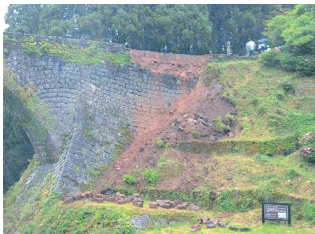
崩落直後 平成 30 年 5 月 7 日（月）撮影
