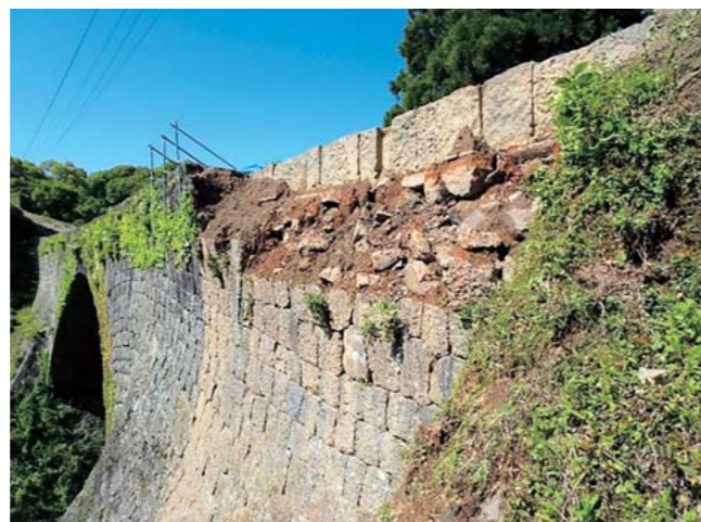
崩落した石垣とむき出しになった通水管側面 平成 30 年 5 月 10 日（木）撮影
