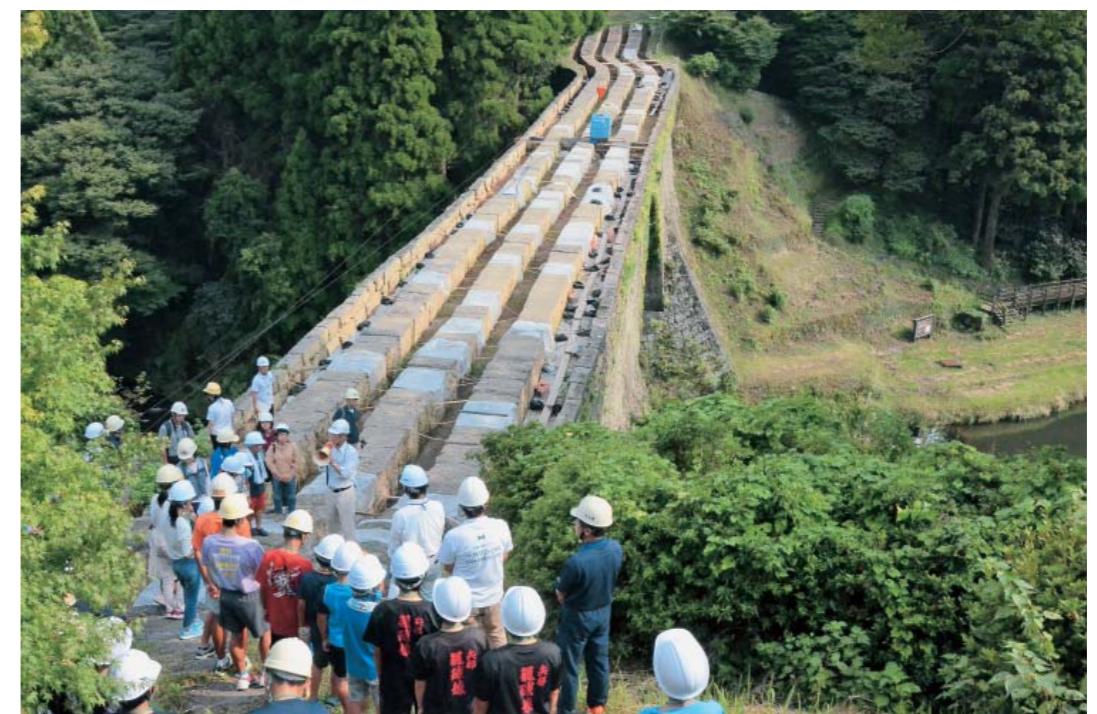
17年ぶりに姿を現した3列の通水管の全貌
