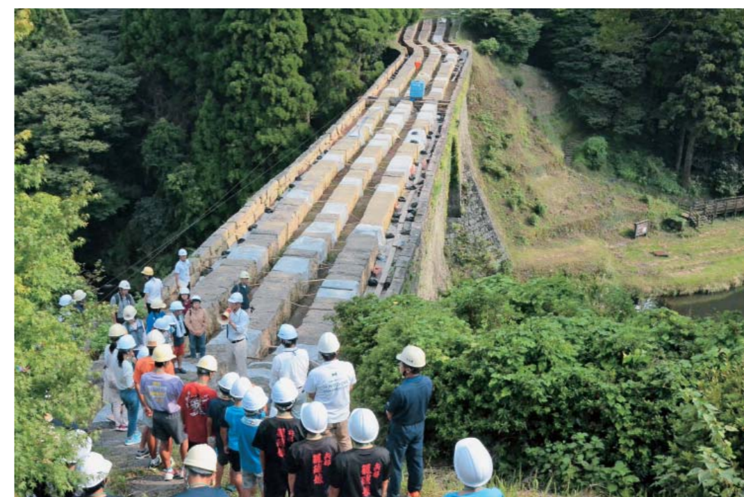
17年ぶりに姿を現した3列の通水管の全貌
