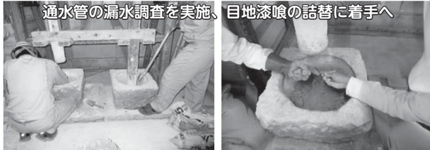
いよいよ通水管の修理に着手するため、通水試験を行い、漏水状況の調査を実施しました。第1回目の試験では、石管の継目からの漏水が約70箇所確認されました。通潤橋の通水管は、1列あたり200個を超える石管を繋ぎ合わせ、それぞれの継目の目地に「漆喰（しっくい）」を詰め、漏水を防ぐ構造となっています。昨年の熊本地震直後、また今回の試験により確認された漏水は、漆喰部分の損傷が原因と考えられます。漆喰は、通潤橋の建造に関する技術などを記した古文書「通潤橋仕法書」に記載される方法を踏襲し、赤土、白灰（現在は消石灰）、砂、塩、松葉汁（松葉を炊いた煮汁）を混ぜ合わせ製作されます。今後は、漏水箇所の目地漆喰の詰め替えを行い、通潤橋の通水機能の復旧を目指します。（※写真は、漆喰の製作中の様子）
