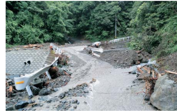
過年度公共土木施設災害復旧事業
