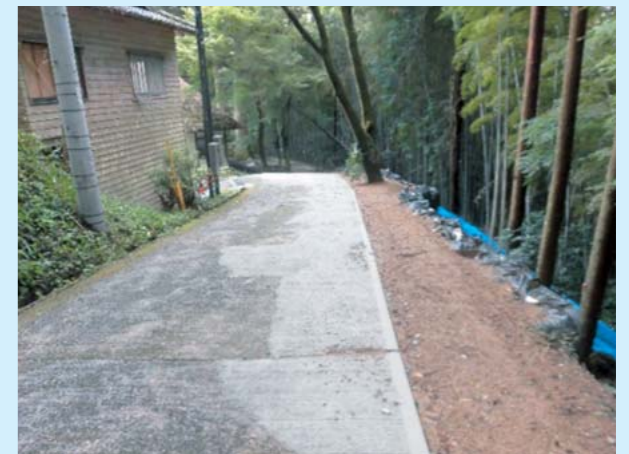
仮復旧後の布田神社横から御小屋までの作業道
