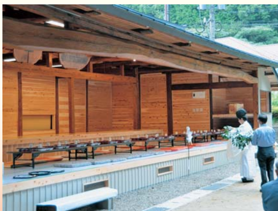
立派な農村舞台が完成しました
