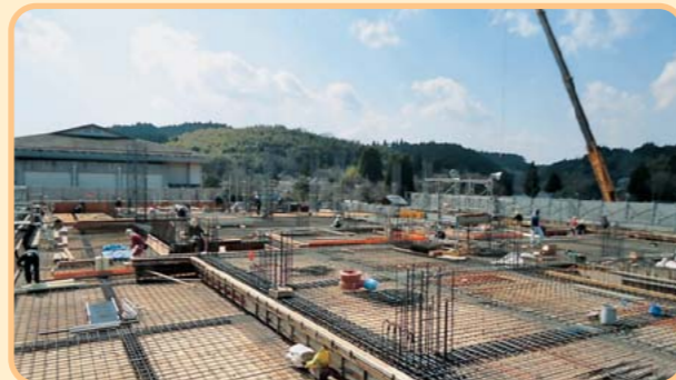
2階床の鉄筋・型枠組立 (平成24年3月29日撮影)
