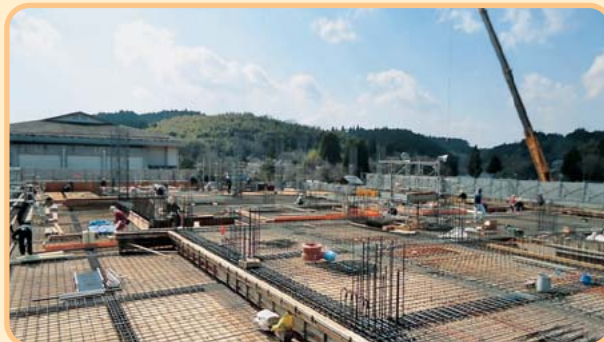
2階床の鉄筋・型枠組立 (平成24年3月29日撮影)
