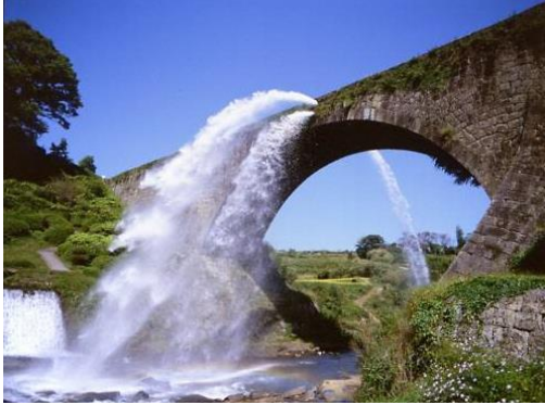
①通潤橋（国指定重要文化財）
