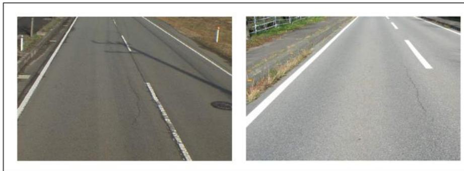
損傷レベル：中（ひび割れ率 20～40%程度）
