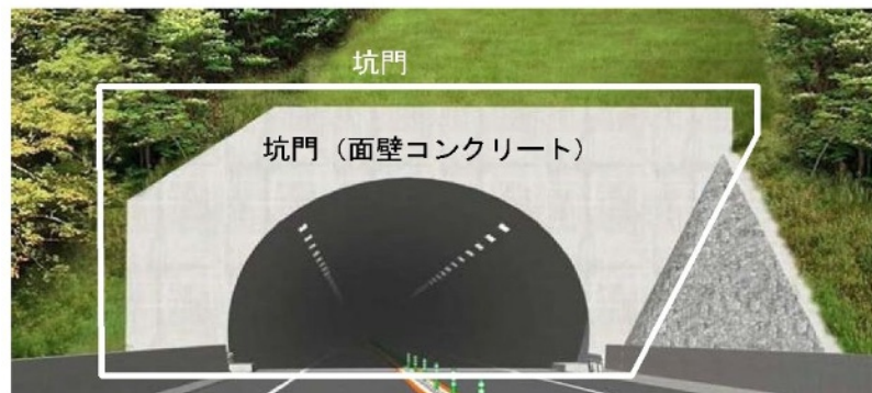
図 2-5 点検対象箇所（トンネル坑口部）
