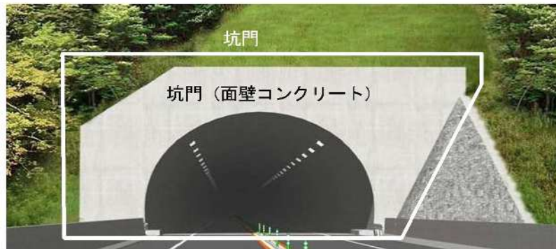
図 2-5 点検対象箇所（トンネル坑口部）
