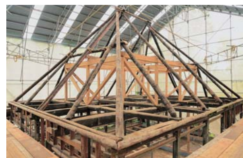
屋根の解体状況
