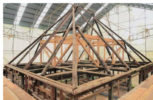
屋根の解体状況
