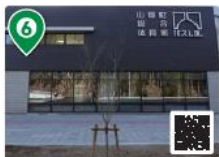
山都町総合体育館パステル
