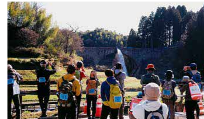
通潤橋特別放水の様子
