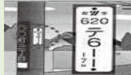
電柱の管理番号
