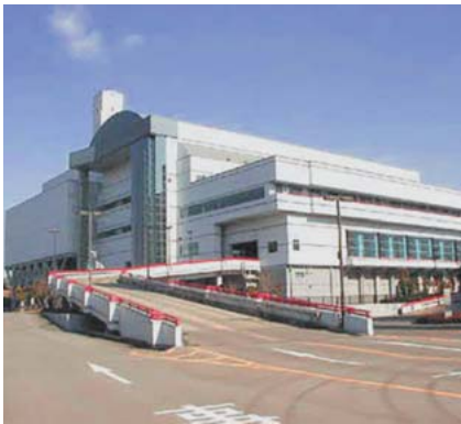
令和7年度から処理委託している東部環境工場（熊本市東区戸島）
