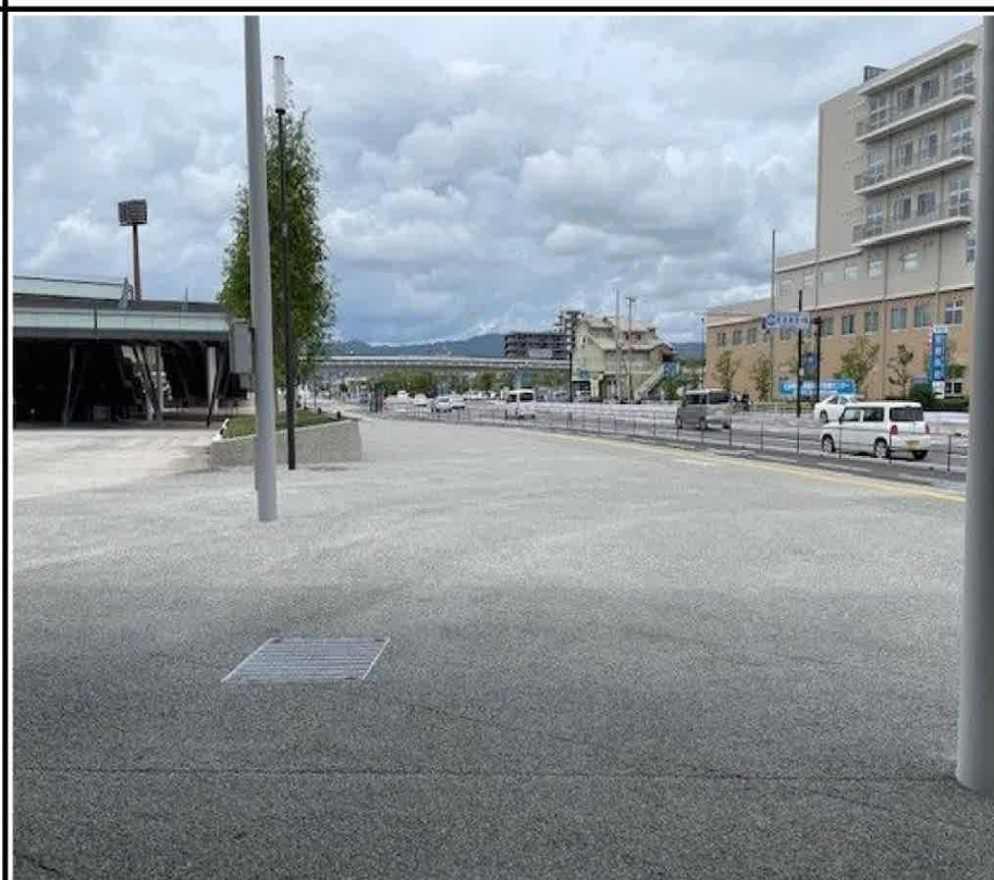
透水性コンクリート洗い出し舗装
