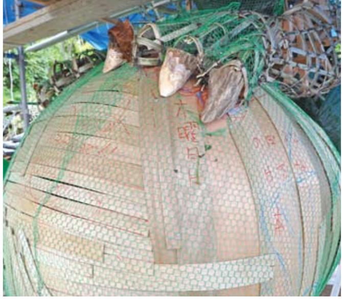
球体の骨組みに沿って、薄いベニア板を細く切って貼り付けることで下地も球体に。
