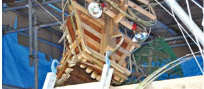
大造り物は顔が最も重要な部分の一つ。骨組みで基礎が決まります。
