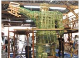
柔らかい金網は骨組みの形状に沿って加工ができるので重宝されます。
