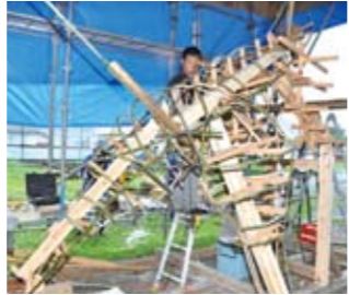
中心に直径の太い角材。その周りを小径木や竹で覆います。
