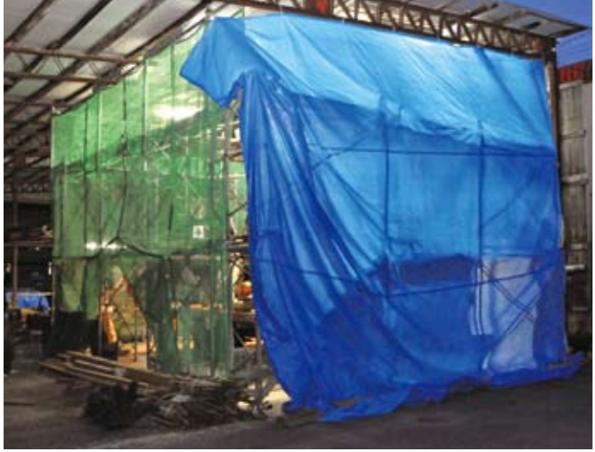
夜間の作業では照明を付けて行われます。
