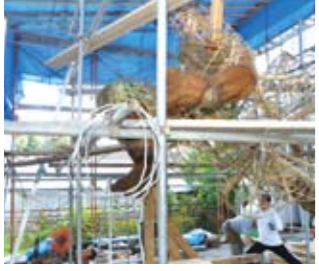
作業がしやすいように橋が渡されています。
