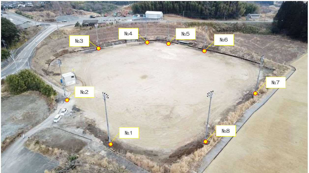
中央グラウンド（照明設置状況）
