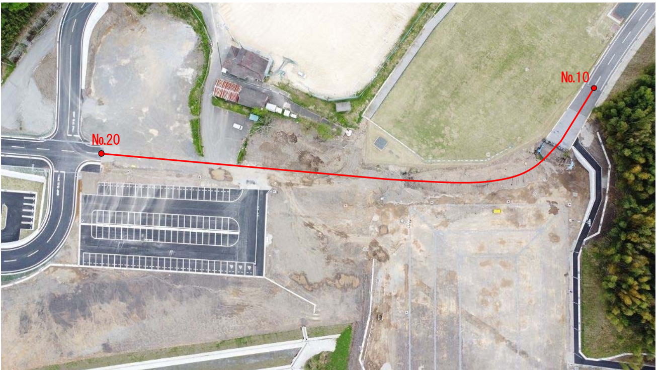
施工範囲（全景）
