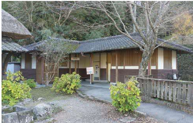
道の駅の老朽化したトイレ
