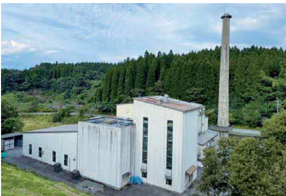
稼働後30年が経過している 小峰クリーンセンター
