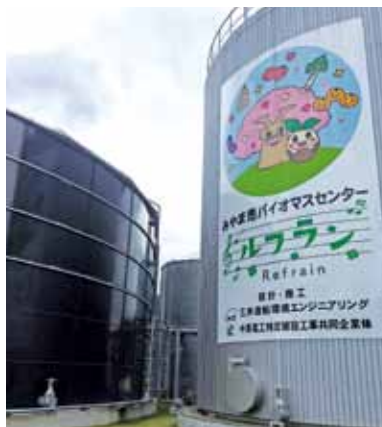
みやま市(福岡県)バイオマス発電施設
