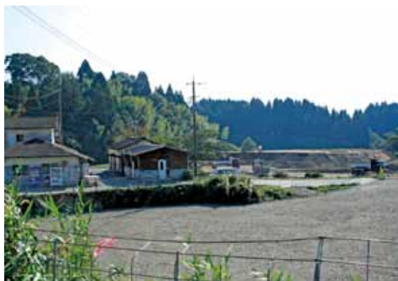
造成工事が進む町営中央グラウンド周辺
