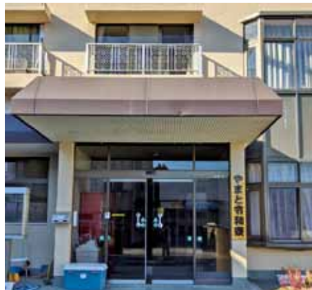
令和寮の外観
