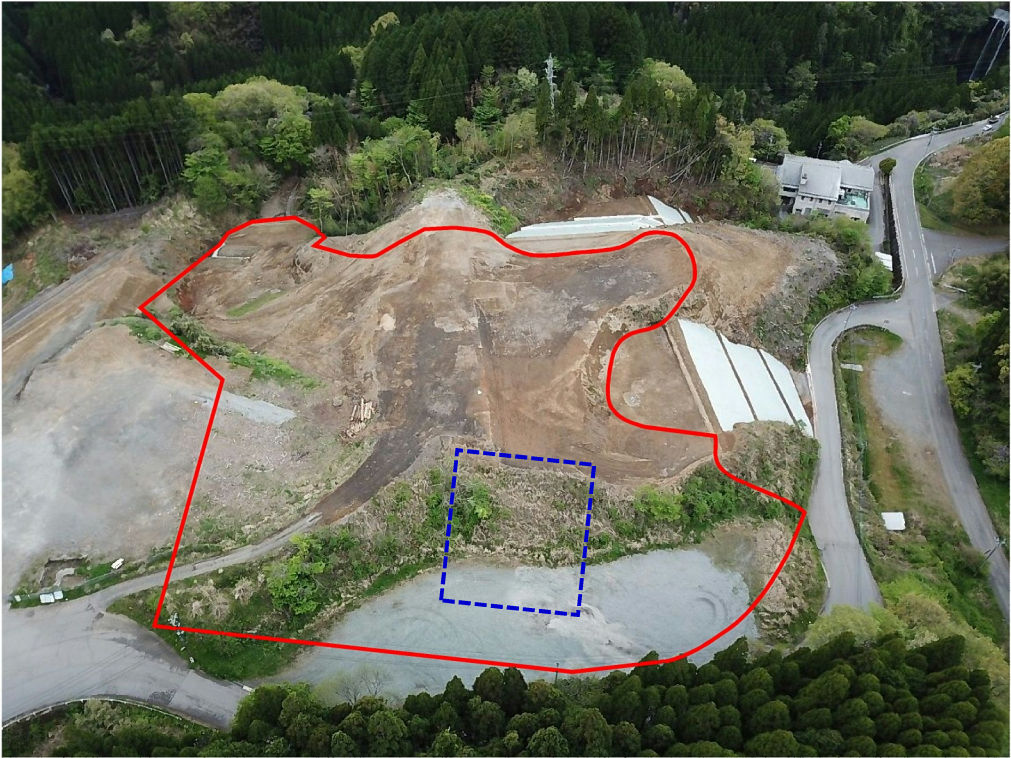
① 東側より全景
