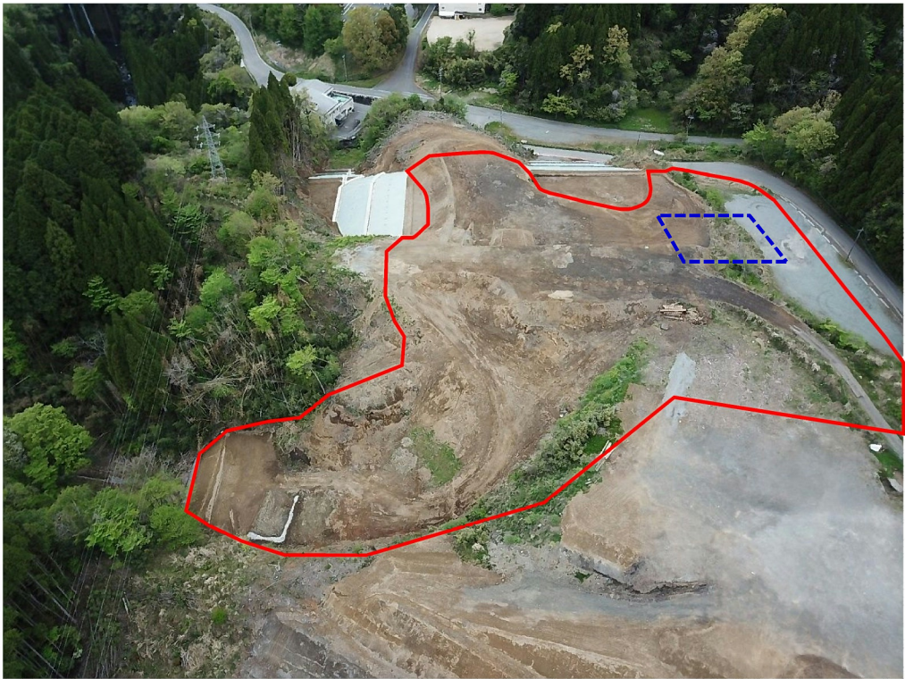
④ 南側より全景
