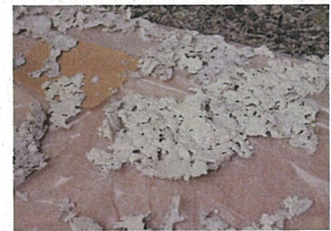
3. 撤去したアスベスト含有材は二重梱包の上、処分
