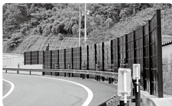
山都中島西ICの遮光フェンス
