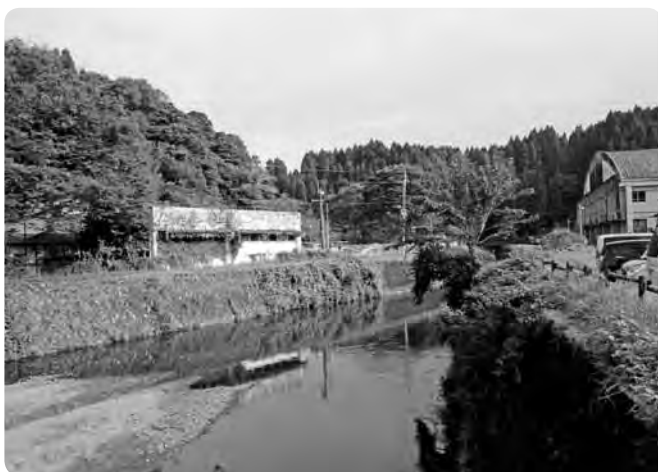
五老ヶ滝川に仮橋を設置し工事が始まる
