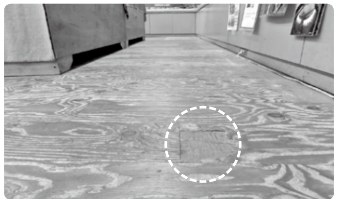
老朽化して化粧板が剥げている道の駅通潤橋物産館の床
