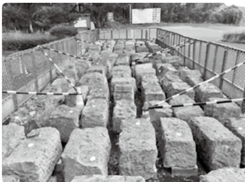
崩落した通潤橋壁石の壁石94個
