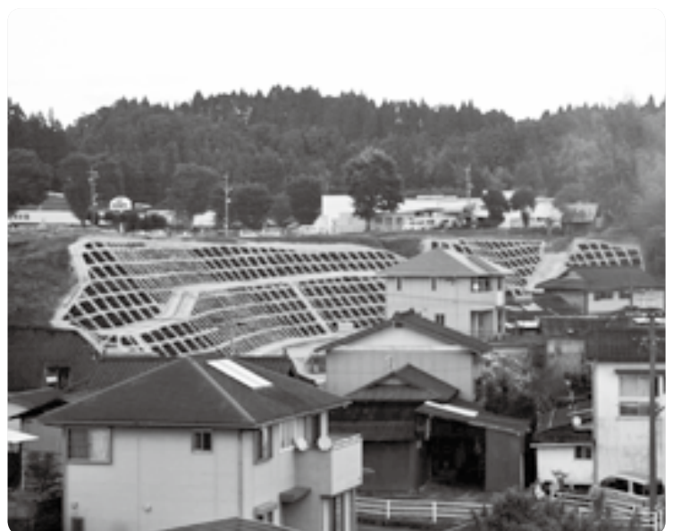
矢部高校北側の宅地裏がけ地工事
