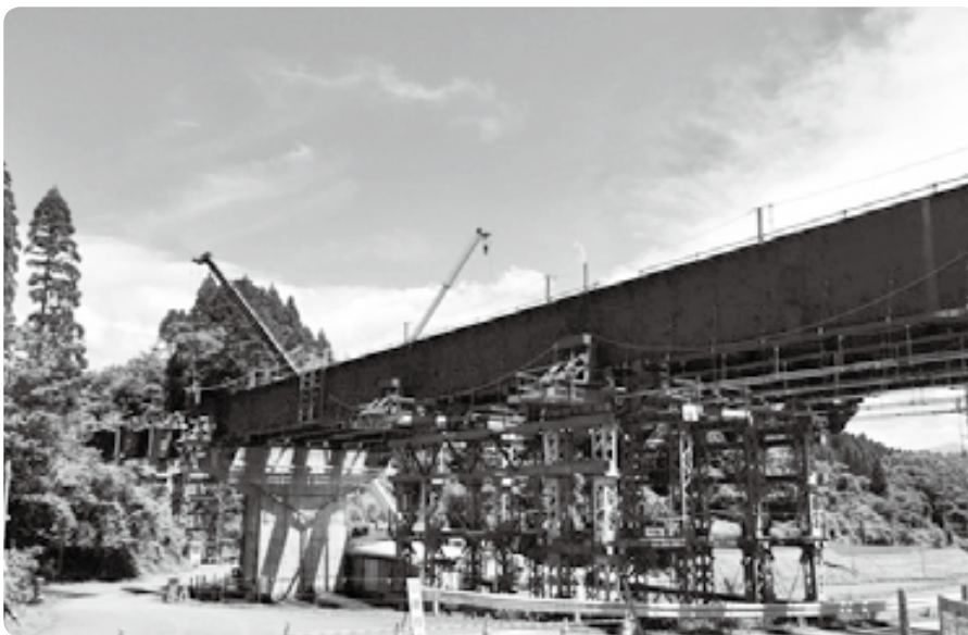
町道上寺造別当線と町道大野城平線の交差点付近で建設中の橋梁(九州中央自動車道)
