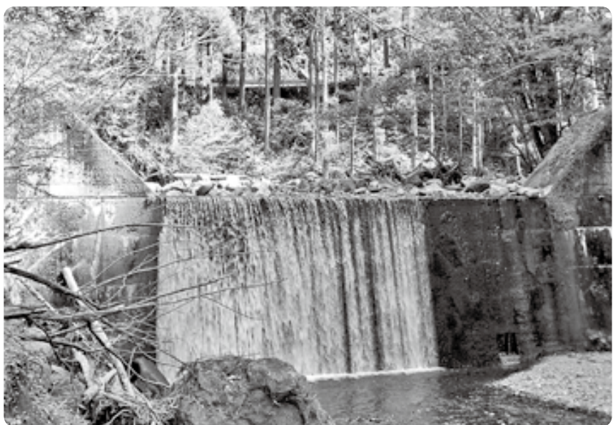
緑仙峡 水の森交流館裏の砂防堰堤(ダム)
