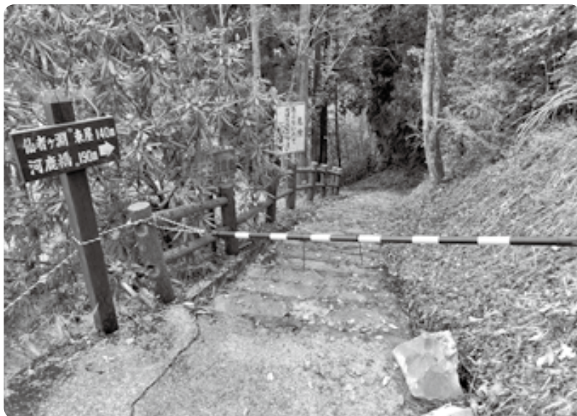
吊り橋から奥には行けない、五老ヶ滝周辺の遊歩道。
