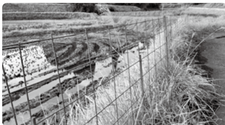
施工されたワイヤーメッシュの様子
