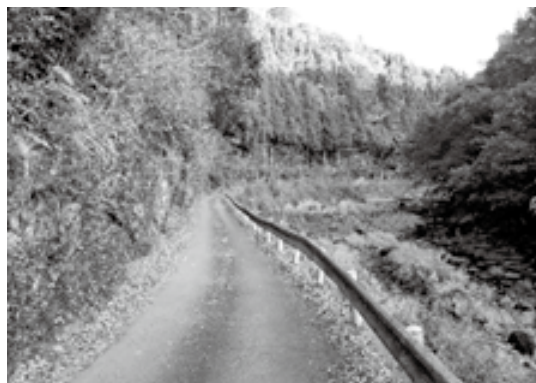
町道瀬戸福良線未着工部分
