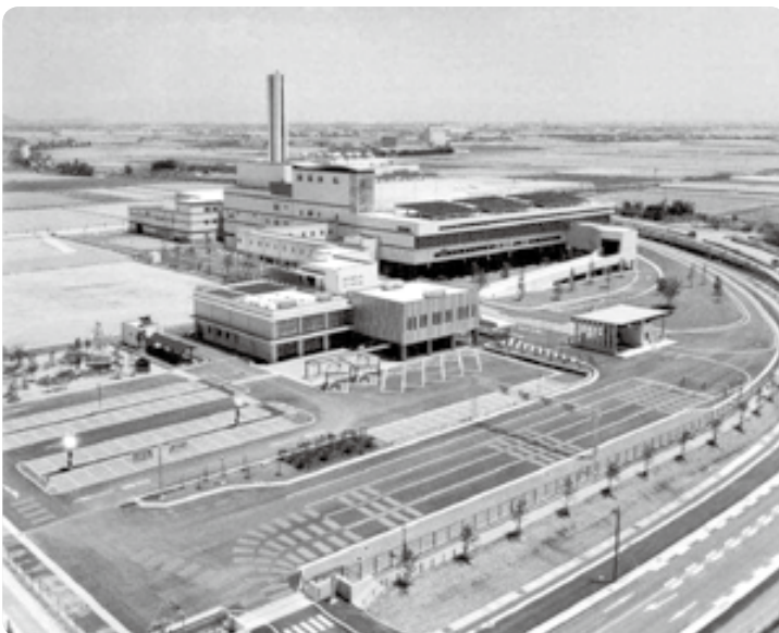
宮の陣クリーンセンター（久留米市）
