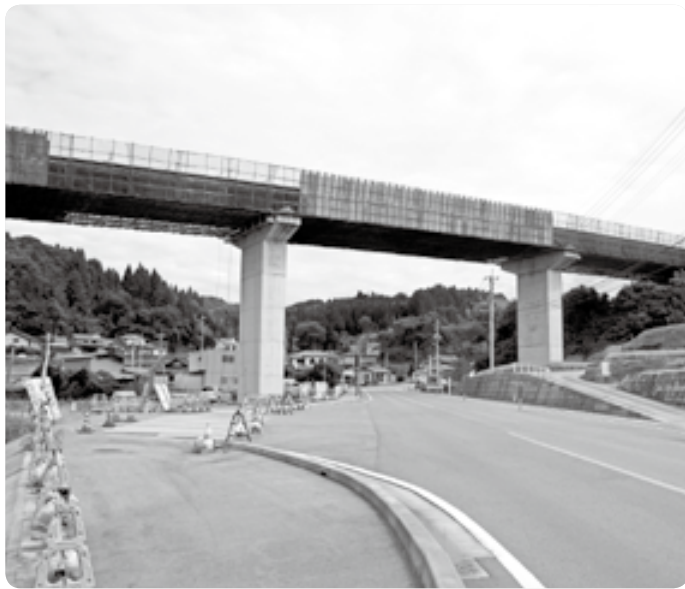
九州中央道工事現場(中島付近)
