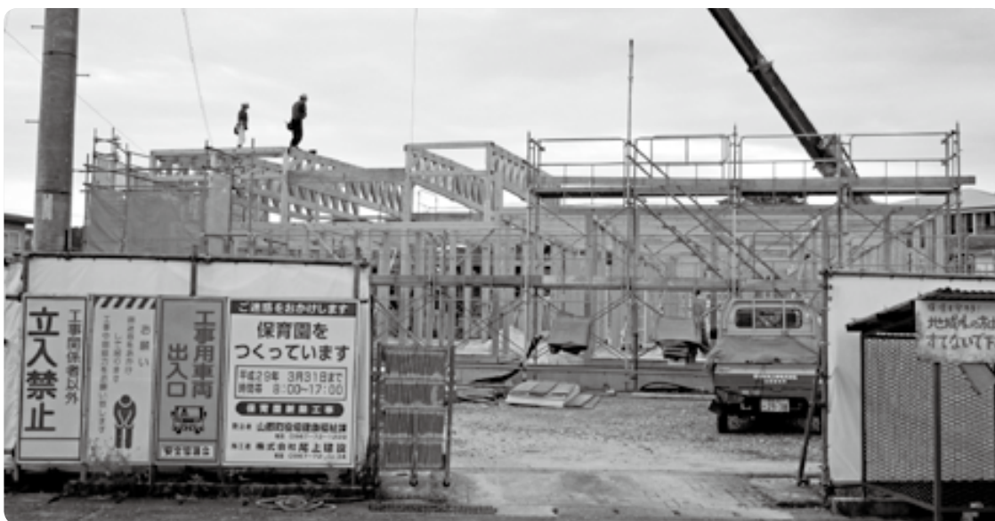
▲建設が進む統合保育園
