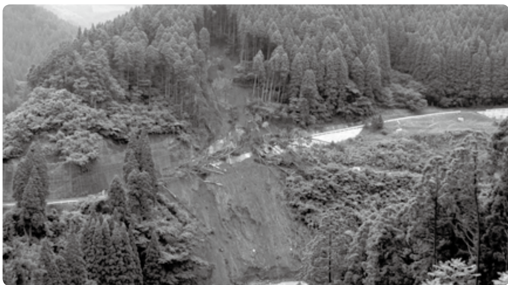
▲横野矢部線崩落現場
