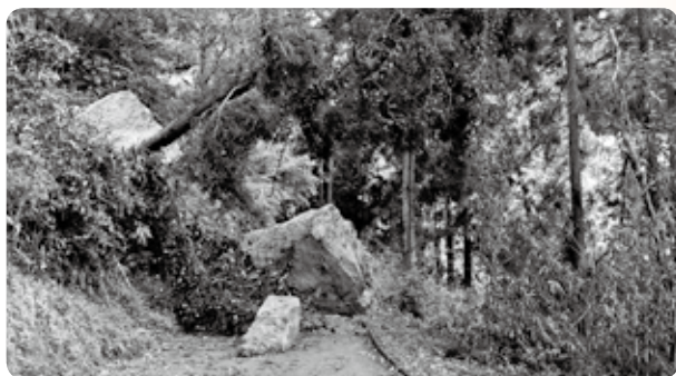
落石被害にあった町道
