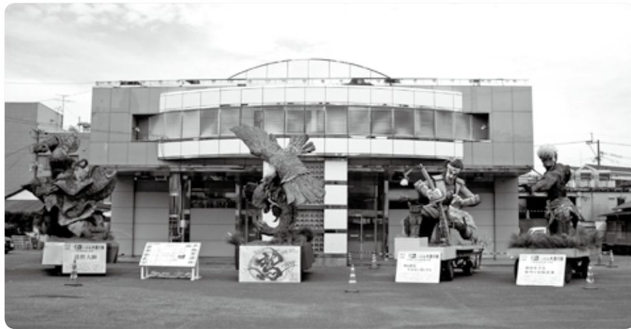
解体される旧浜町会館
