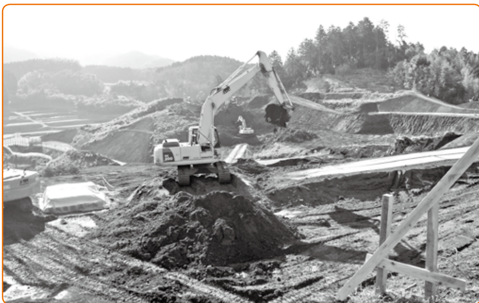
九州中央自動車道建設現場(中島地区)
