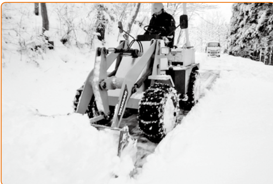
道路の除雪作業
