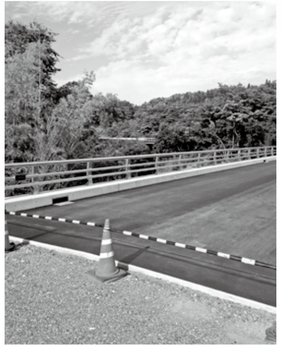
仁田尾大橋近景
