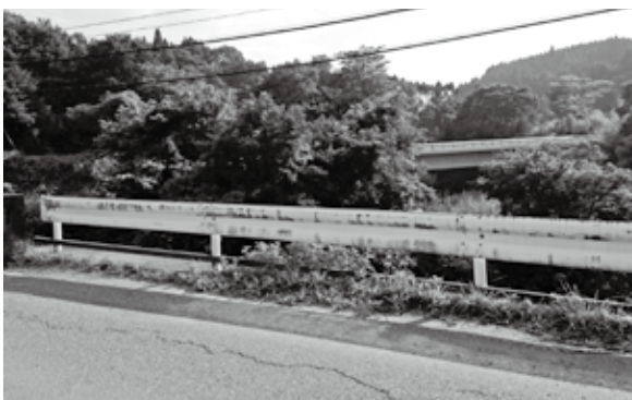
◀大川大矢線 「仁田尾大橋」の工事現場手前が旧橋、奥が新橋
