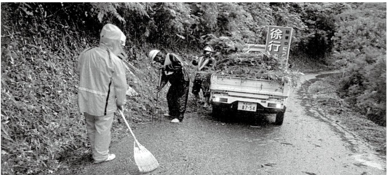
路肩除草作業
