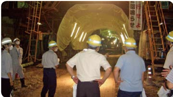
田代第一トンネル
