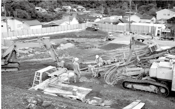
新庁舎工事現場
