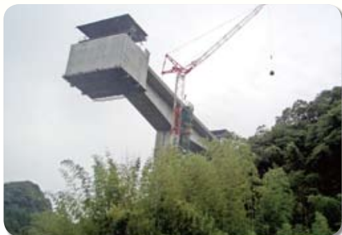
八勢川橋上部工
