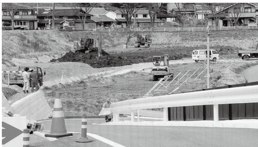
繰越事業：国道218号から新庁舎への取付工事
