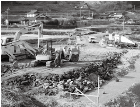
急ピッチで進む国道への取付け道路工事
