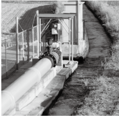
大分県竹田市の水力発電施設 事業費5,000万円最大出力25kw
