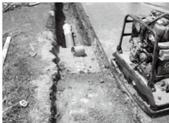
水道工事現場
